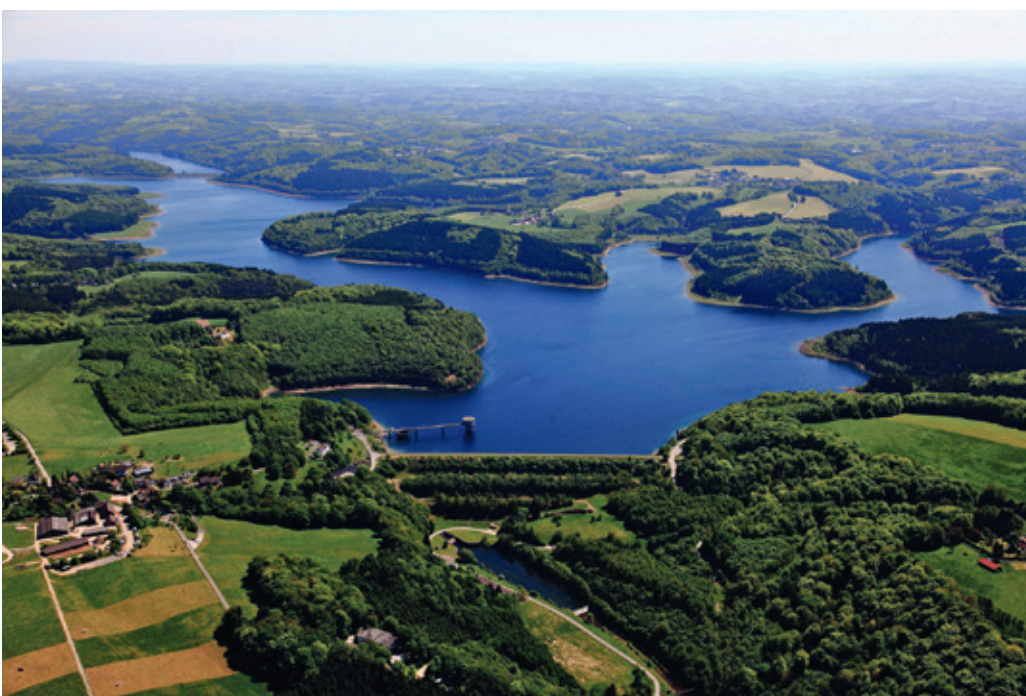
Abb. 3: Luftaufnahme der Großen Dhünntalsperre
